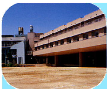
院庭を囲む病棟外観
